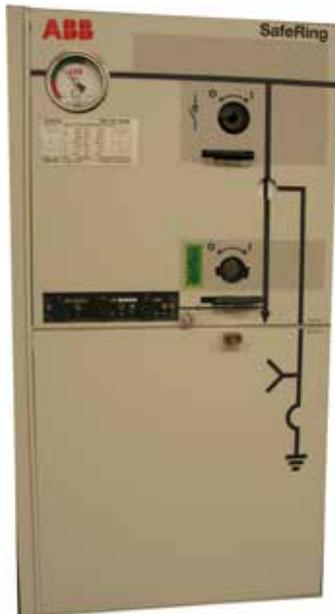
В качестве дополнительного оборудования, модули C и De могут оборудоваться втулками для испытания кабелей, которые расположены за нижней передней крышкой. Эта крышка может иметь блокировку в зависимости от положения заземлителя, что позволит исключить доступ к втулкам до того как заземлитель будет замкнут.
